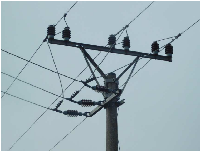
PR - propojení vodičů v různých rovinách
