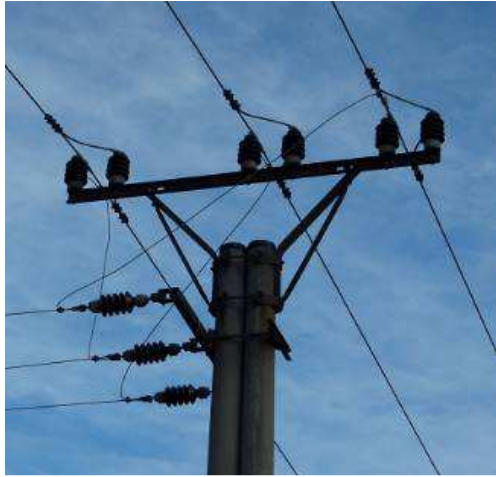
O - odbočka - od sloupu odbočuje 1 či více dalších linek 4. materiál, ze kterého je sloup zhotoven
