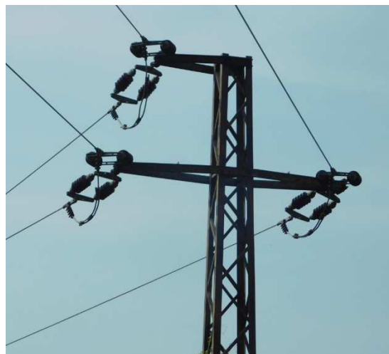
R - rohový sloup - linka mění směr
