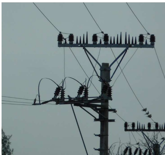
SUO - spodní úsekový odpínač (tato kategorie později sloučena s PR)
