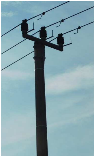
JI - jiskřič (ochrana proti přepětí)
